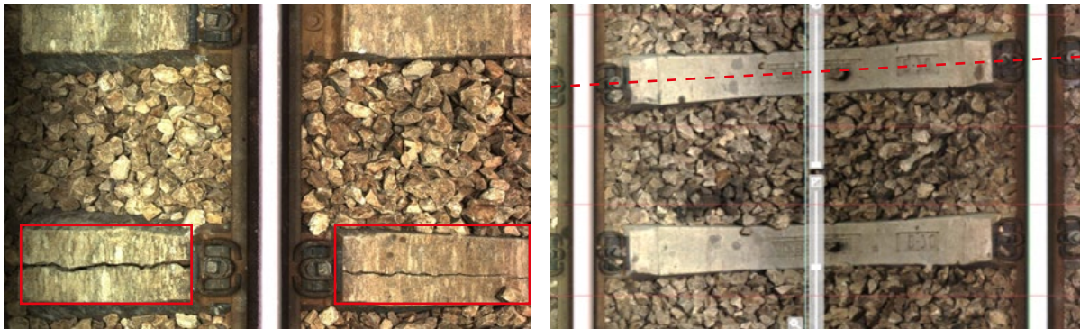
Erkennung von Fehlern an Schwellen- und Schienenbefestigungselementen: Schwellenrisse (links), Verdrehte Schwelle (rechts)
